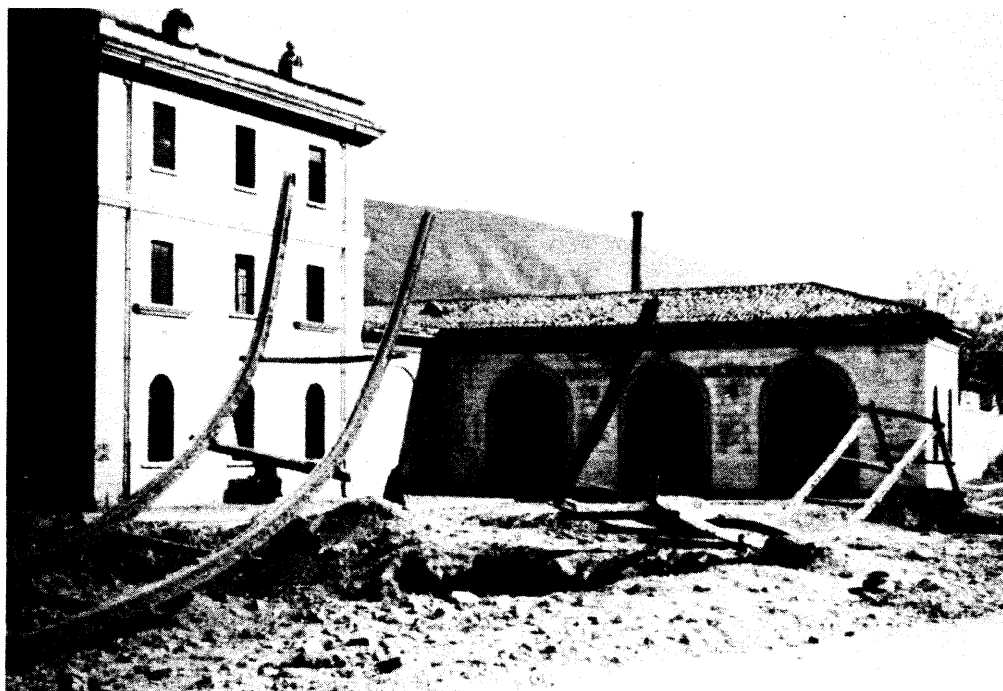
Brescia, 2 marzo '45. Binari divelti in piazzale Cremona di fronte al vecchio mercato del pesce.
