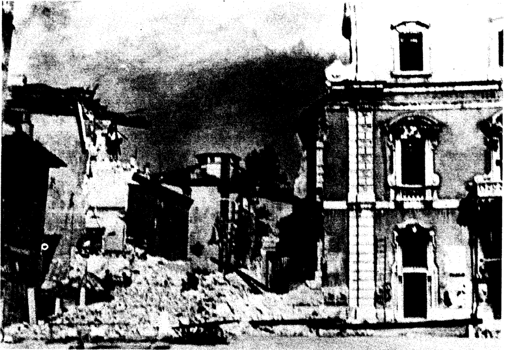
Brescia, 24 febbraio '45. Distruzione in piazza delle Erbe
