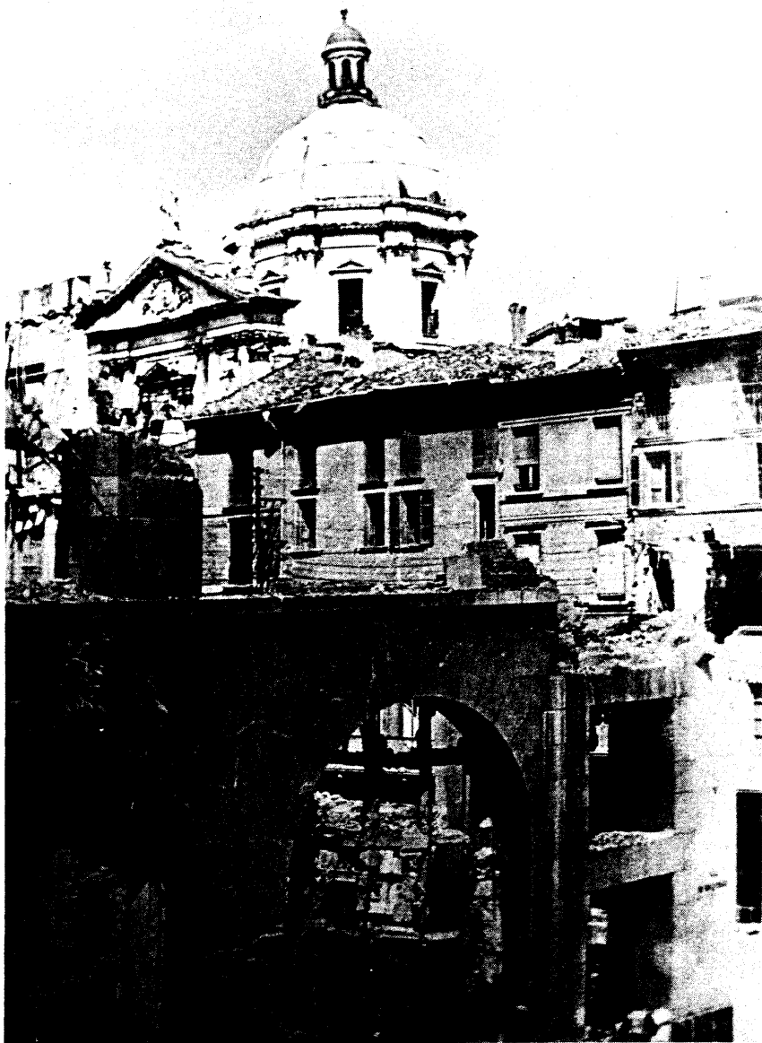
Brescia, 13 luglio '44. La cupola del Duomo vista da piazza della Vittoria dopo il bombardamento
